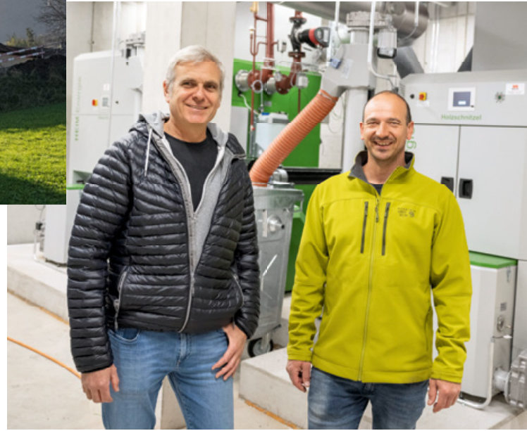
Reto Cossalter (à gauche) et Christoph Zwicky devant les deux grands fours à bûches de la nouvelle centrale de chauffage.
