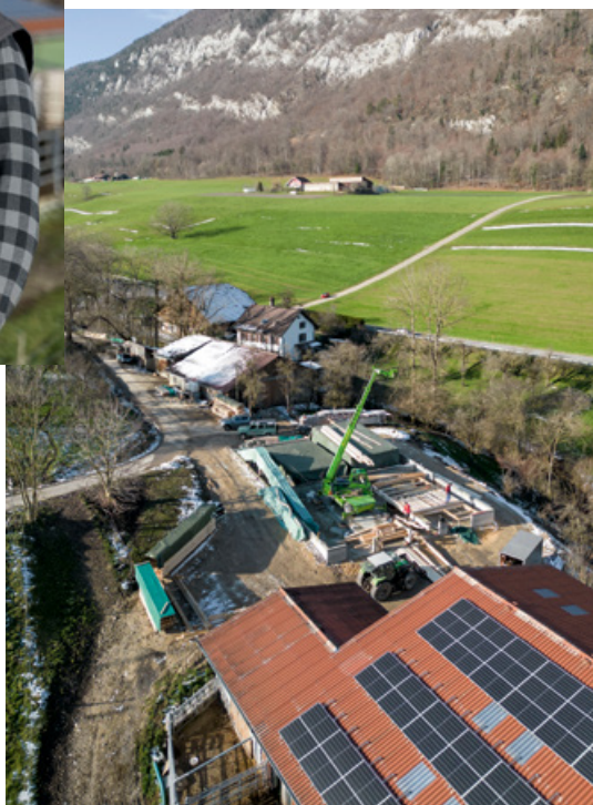
D'autres panneaux solaires sont installés sur la grange en construction.
