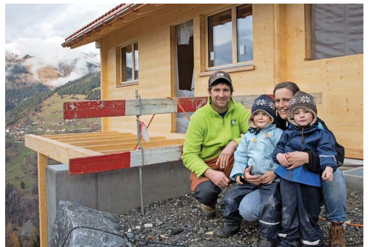
La nouvelle maison d'habitation de la famille Zumbrunn se construit à proximité de l'étable.
