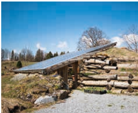
On dirait la maison d'un hobbit. C'est en réalité un walipini, une serre construite dans la terre.
